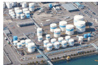
次世代バイオ燃料の備蓄・出荷基地である、当社の塩釜貞山油槽所
