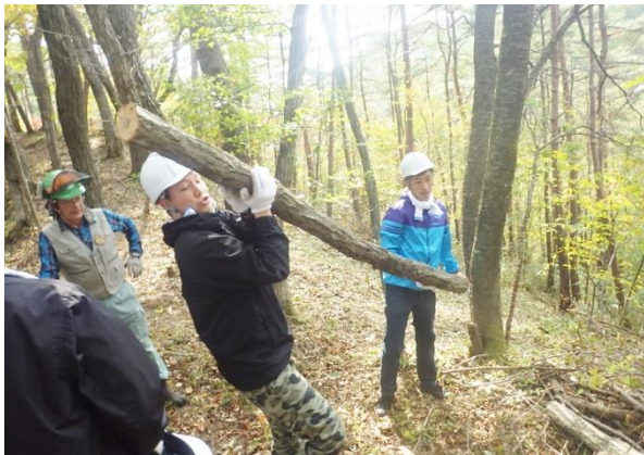
遊歩道整備の様子
