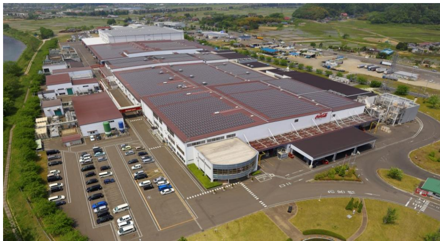
(太陽光発電所の全景)
