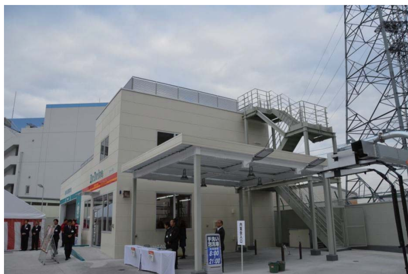
(高さ7メートルの事務所棟。右側の外階段から屋上へ避難が可能)
